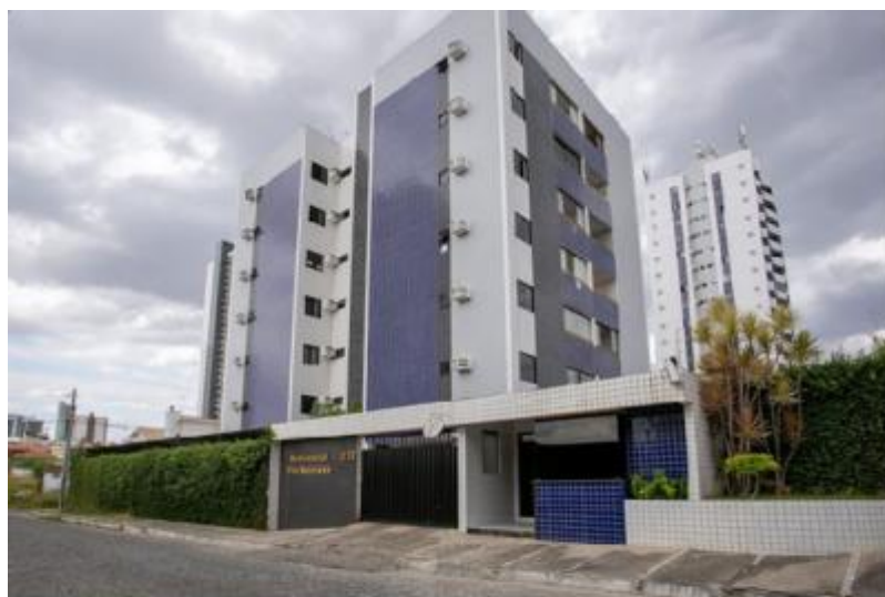
Residencial Vila Madalena Fonte: Nordeste Construções
