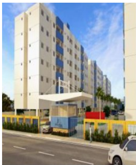
Após Conclusão – T. SANHAUA
