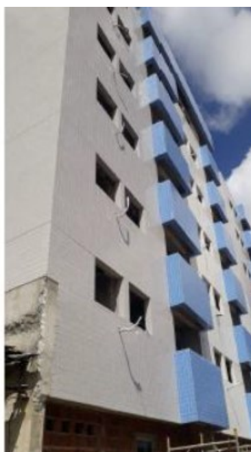
Obra em andamento - T Sanhauá
