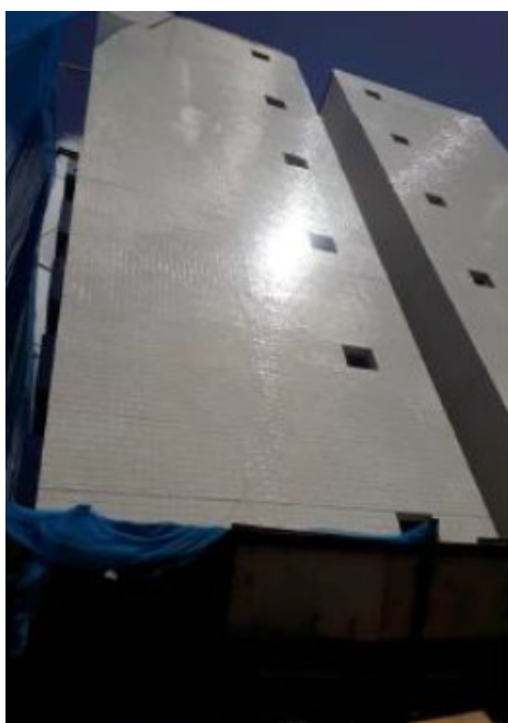
Obra em andamento - T Sanhauá
