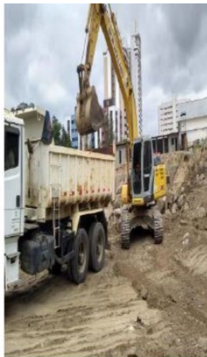
Obra em Andamento – HUMANY
