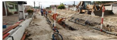
Obra da Rede coletora de Esgoto
