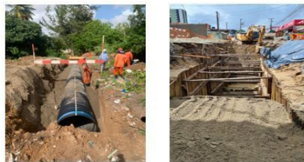
Manutenção Esgotos Av. Beira Rio em JPA
