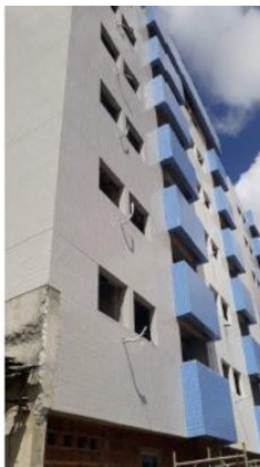
Obra em andamento - T Sanhauá
