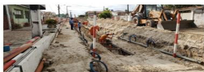
Obra da Rede coletora de Esgoto
