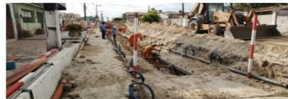
Obra da Rede coletora de Esgoto
