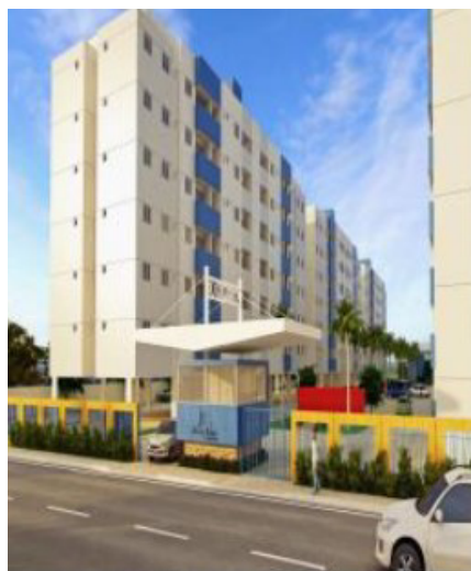
Após Conclusão – T. SANHAUA
