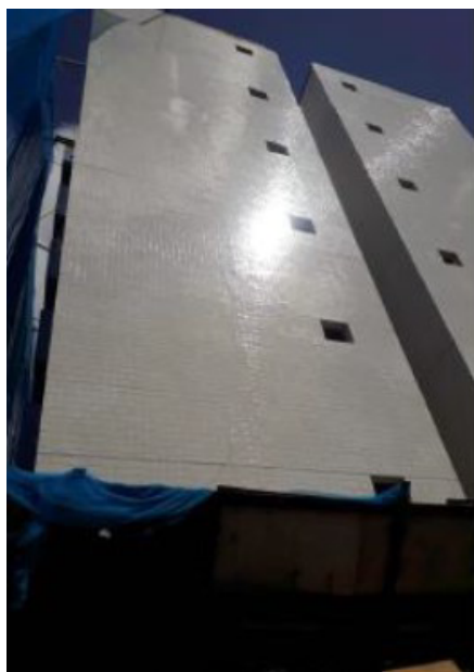
Obra em andamento - T Sanhauá
