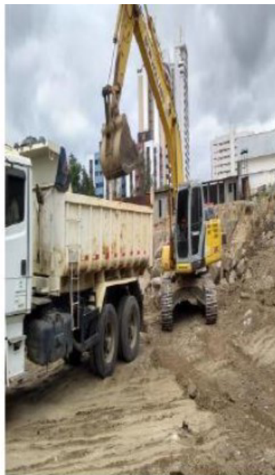
Obra em Andamento – HUMANY
