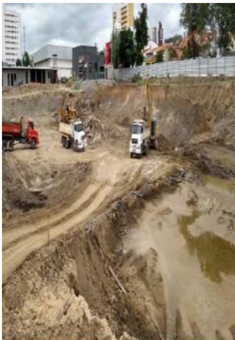
Obra em Andamento – HUMANY
