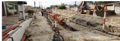
Obra da Rede coletora de Esgoto
