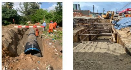
Manutenção Esgotos Av. Beira Rio em JPA
