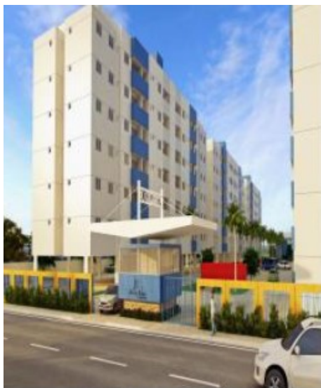
Após Conclusão – T. SANHAUA
