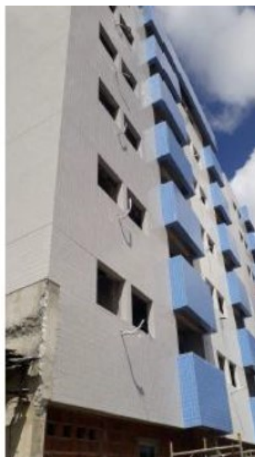
Obra em andamento - T Sanhauá
