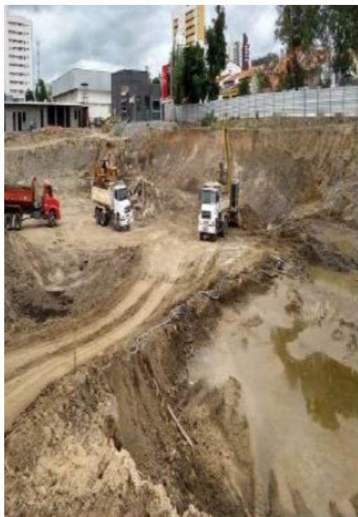
Obra em Andamento – HUMANY
