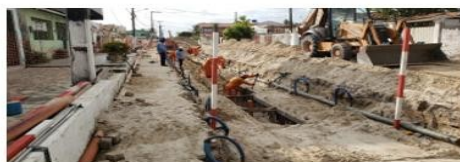
Obra da Rede coletora de Esgoto
