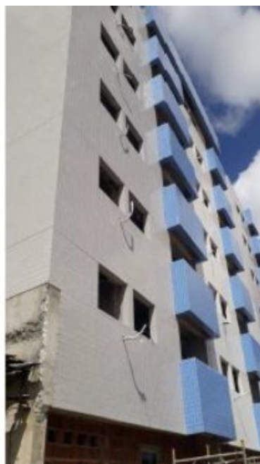
Obra em andamento - T Sanhauá
