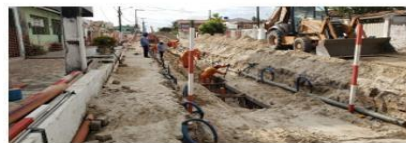
Obra da Rede coletora de Esgoto
