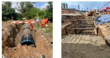
Manutenção Esgotos Av. Beira Rio em JPA
