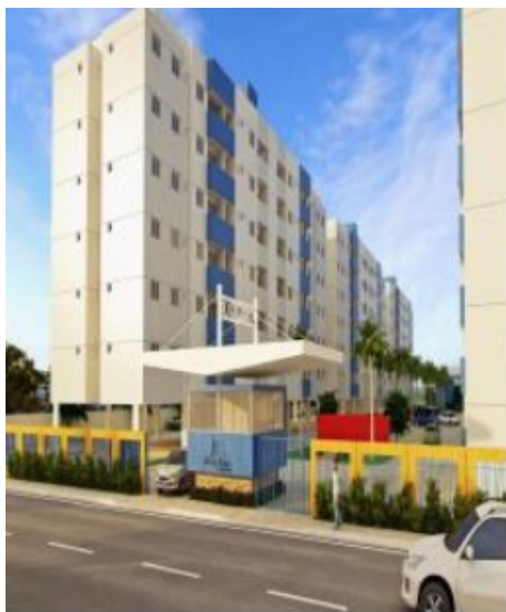
Após Conclusão – T. SANHAUA
