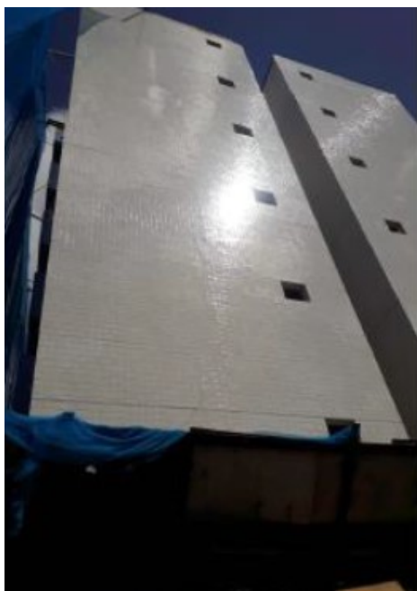
Obra em andamento - T Sanhauá
