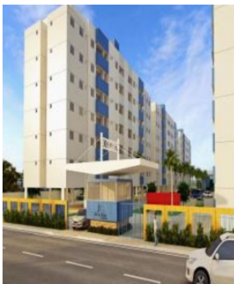
Após Conclusão – T. SANHAUA
