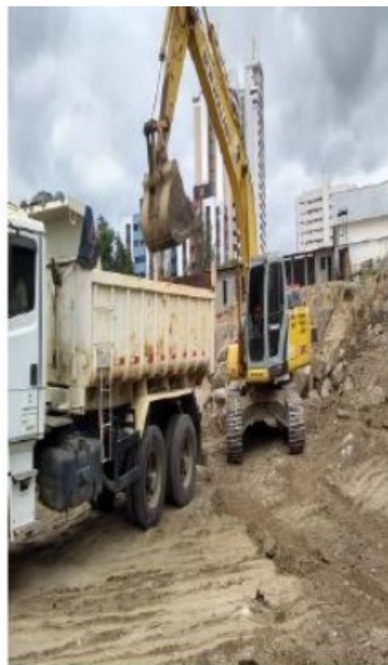
Obra em Andamento – HUMANY
