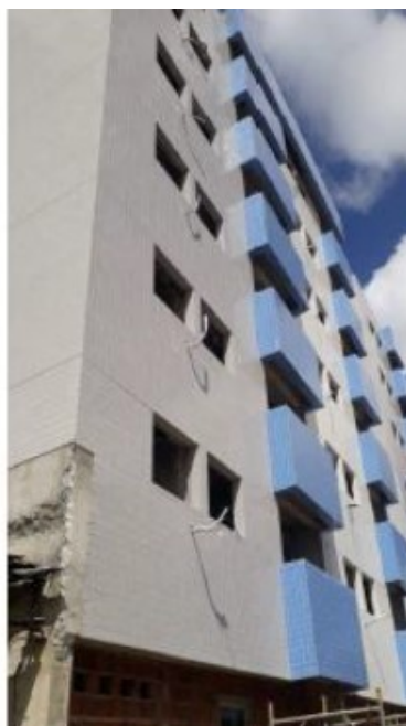
Obra em andamento - T Sanhauá
