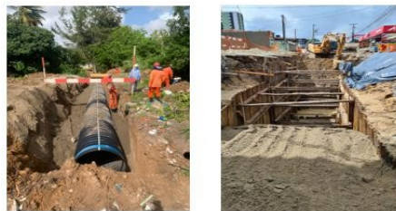
Manutenção Esgotos Av. Beira Rio em JPA
