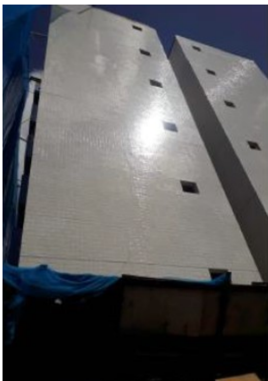
Obra em andamento - T Sanhauá
