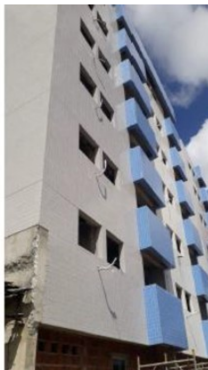
Obra em andamento - T Sanhauá
