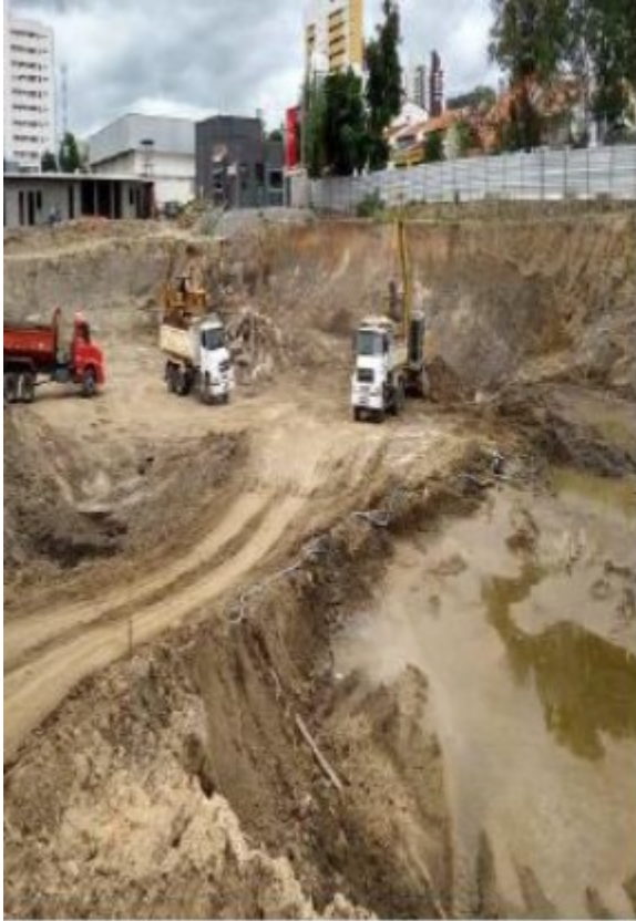
Obra em Andamento – HUMANY
