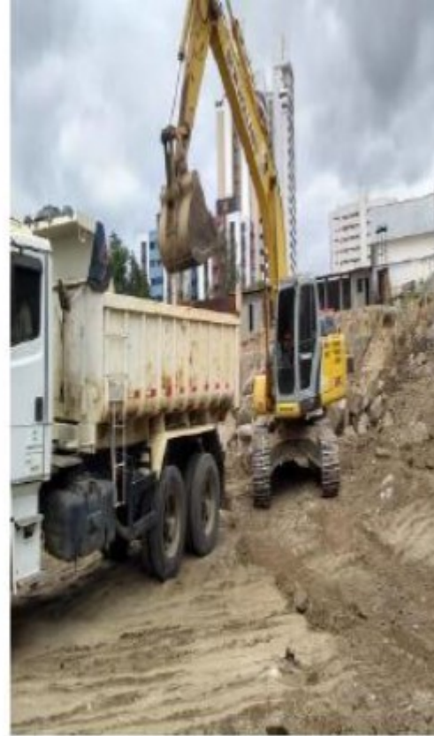
Obra em Andamento – HUMANY
