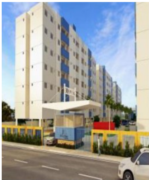
Após Conclusão – T. SANHAUA
