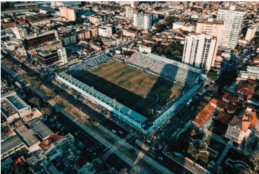
Estádio da Curuzu | Casa do Paysandu
