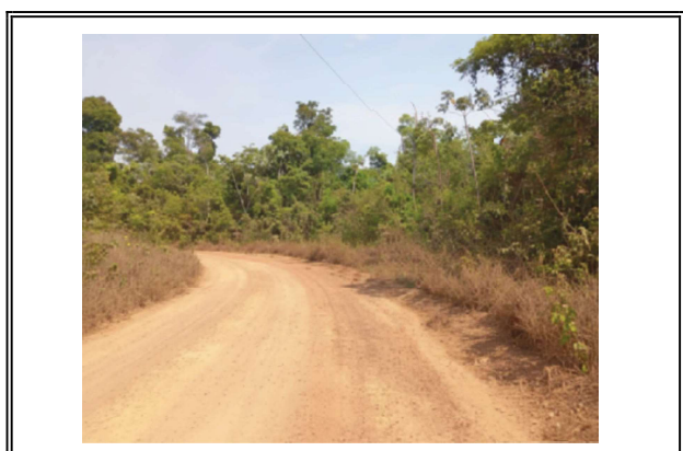
Vicinal de acesso em boas condições e área para limpeza
