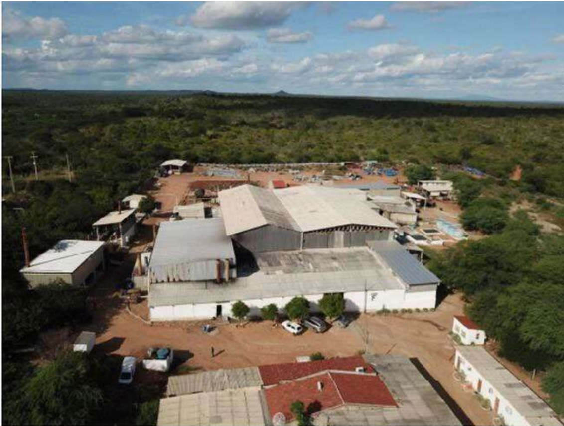
Foto: Fachada do prédio avaliado
