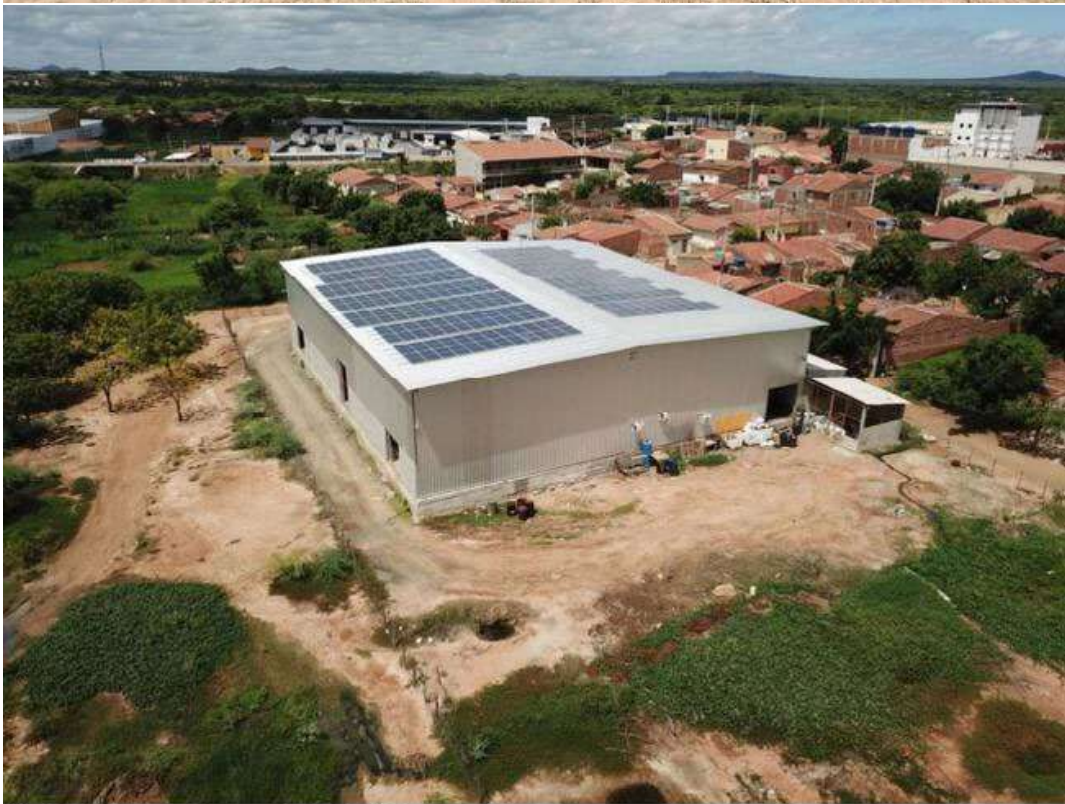
Foto: Fundo e Lateral do Prédio
