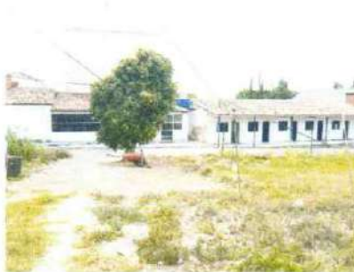
Foto 12- Cozinha, refeitório e dormitórios
