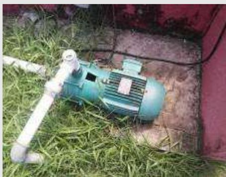
MOTOBOMBA CENTRIFUGA MARCA SCHNEIDER COM MOTOR POT. 5CV | Item: 184 |
