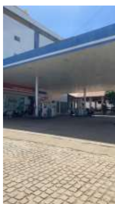
Coberta de bombas
