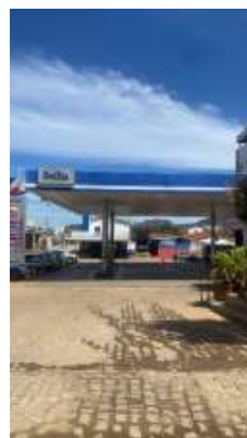
Coberta de bombas
