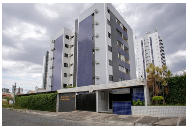
Residencial Vila Madalena Fonte: Nordeste Construções
