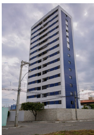
Edifício Flávia Milena Fonte: Nordeste Construções
