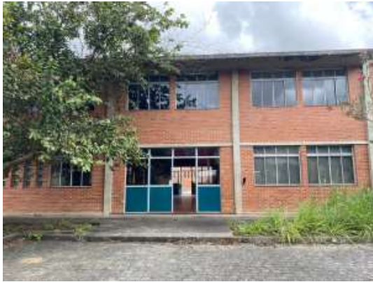
Bloco de serviços
