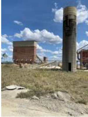
Caixa d'água elevada
