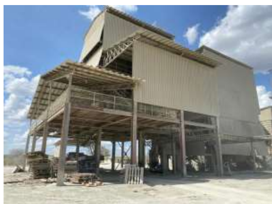
Prédio da ensacadeira
