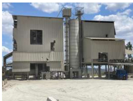
Prédio do moinho
