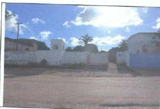
FOTO -1: fachada principal
