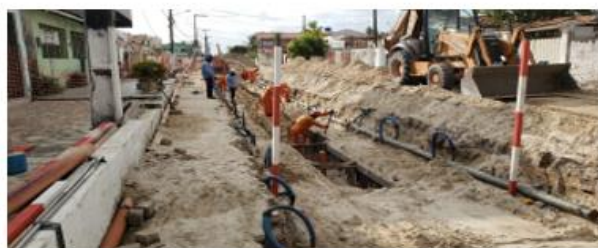
Obra da Rede coletora de Esgoto
