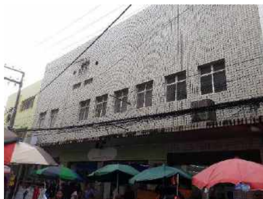
Fachada - Rua das Calçadas
