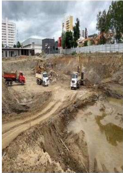
Obra em Andamento – HUMANY
