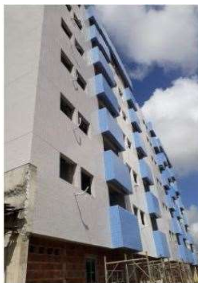
Obra em Andamento – T. SANHAUA
