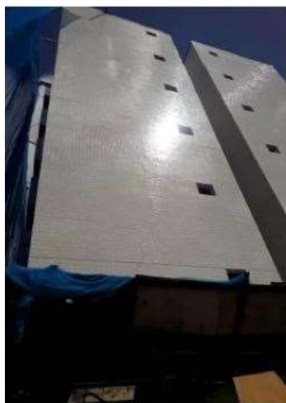
Obra em Andamento – T. SANHAUA
