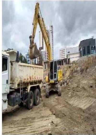
Obra em Andamento – HUMANY
