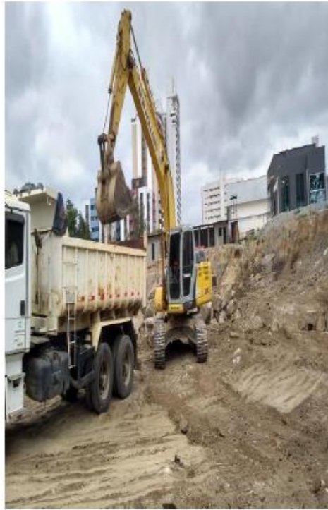
Obra em Andamento – HUMANY
