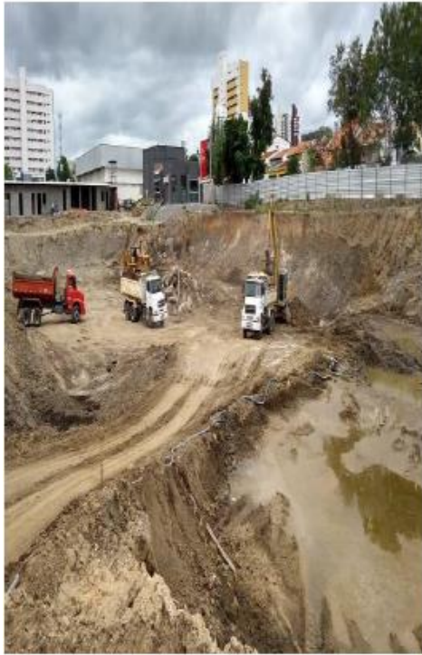
Obra em Andamento – HUMANY
