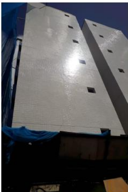
Obra em Andamento – T. SANHAUÁ
