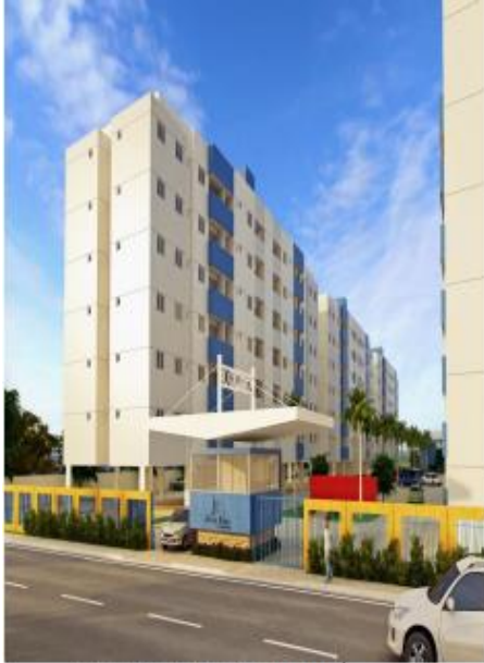
Após Conclusão – T. SANHAUÁ
