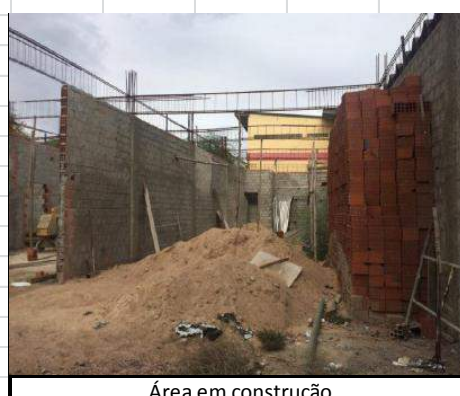
Área em construção
