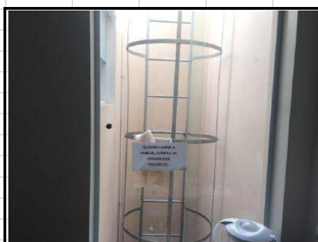
ÁREA DE VENTILAÇÃO
