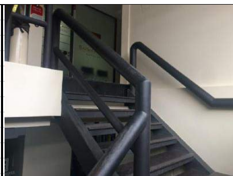
ESCADA DE ACESSO AO 1º PAVIMENTO
