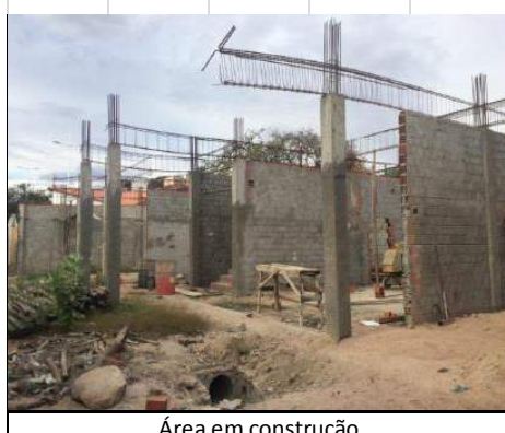
Área em construção
