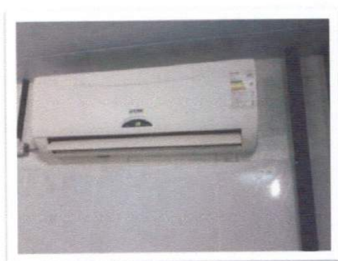
Aparelho de ar condicionado split
