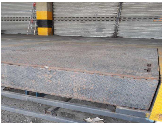
Rampa de plataforma
