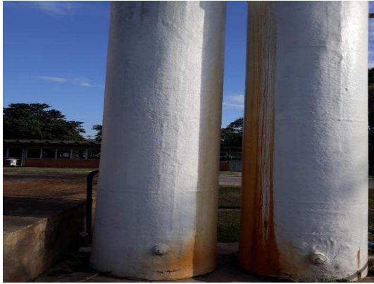
Tanque de água
