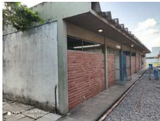
Casa de máquinas
