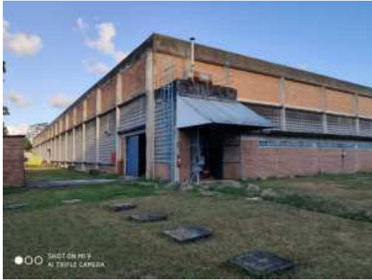
Vista geral Galpão
