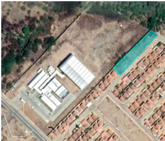
Vista geral imóvel
