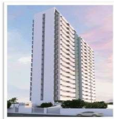
Imagem 4: Edifício Shopping Park Selective
